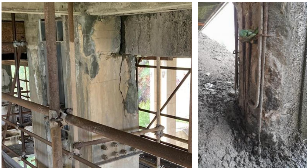
Figura 100 – Ritto A in corrispondenza dell'appoggio della trave tampone lato via Roccella, ritto D all'attacco dell'arco
