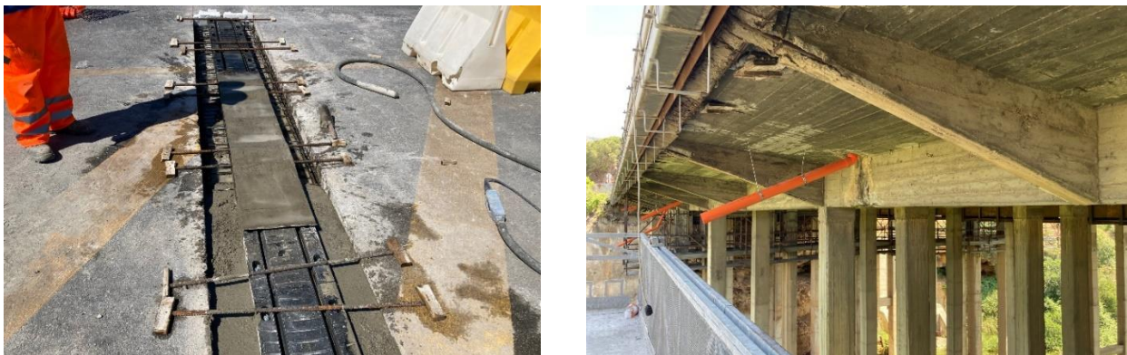
Figura 10 – Interventi sui giunti e interventi per l'allontanamento delle acque meteoriche realizzati nel 2021
