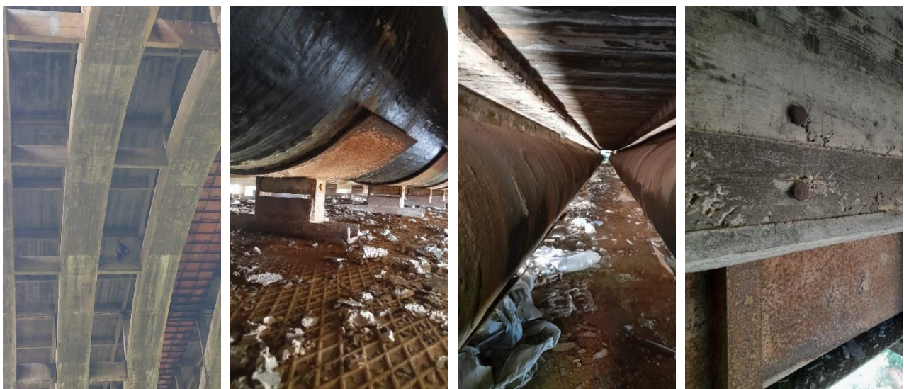
Figura 5 – Cavedio e tubazioni presenti nello spartitraffico
