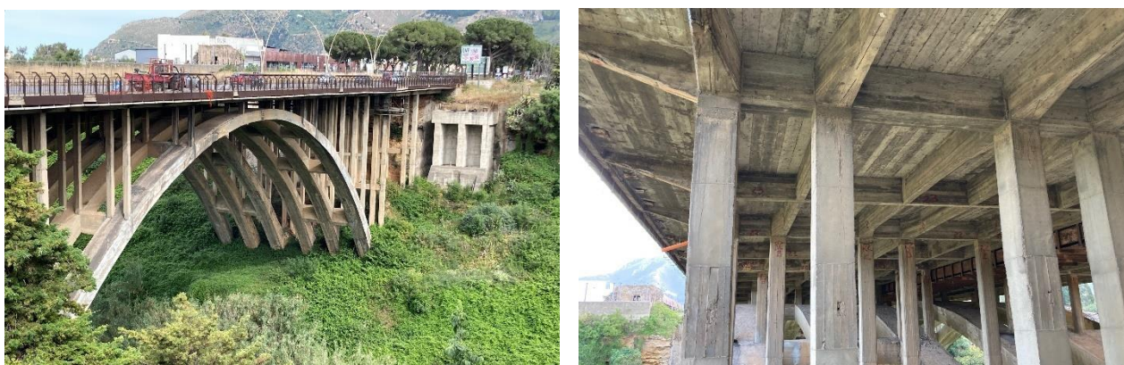
Figura 3 – Viste del ponte
