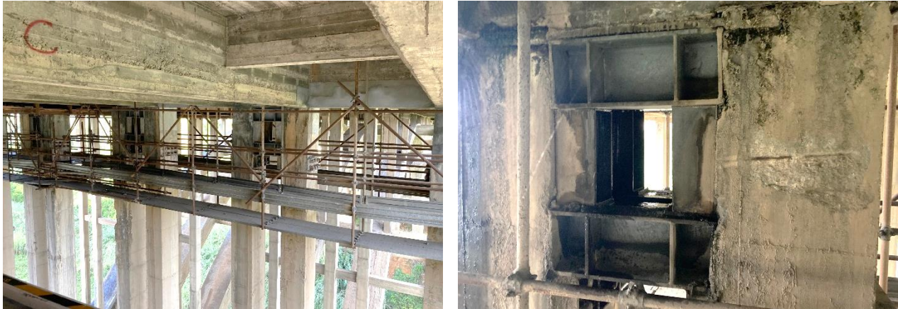
Figura 9 - Intervento di placcaggio realizzato nel 2002 (Foto anno 2021)
