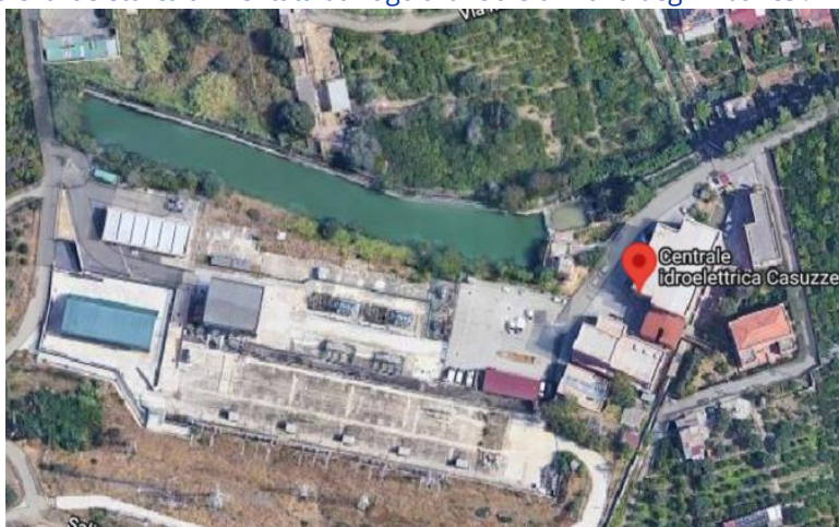
Figura 2-20 – Centrale Idroelettrica Casuzze
